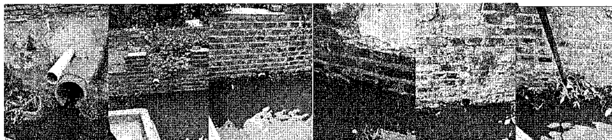
图 1-6 污水管或雨污合流排口图
